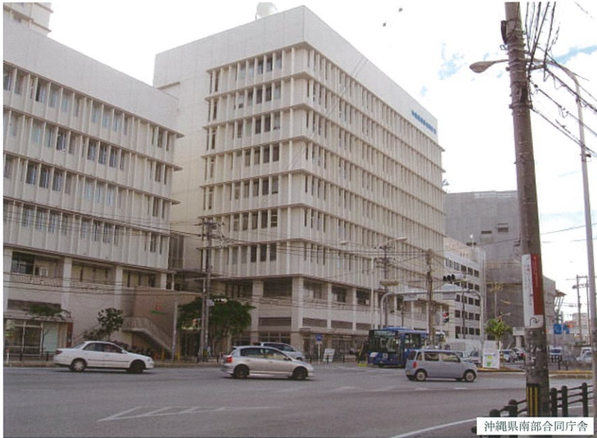
沖縄県南部合同庁舎
