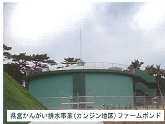
県営かんがい排水事業(カンジン地区)ファームポンド
