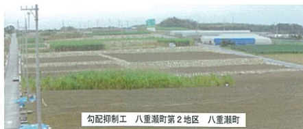
勾配抑制工 八重瀬町第2地区 八重瀬町
