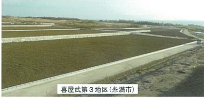
喜屋武第3地区(糸満市)
