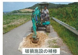
破損施設の補修
